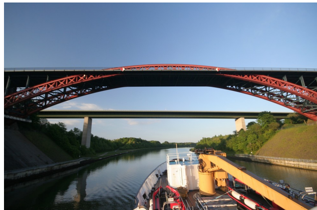
Kiel Canal: Levensau bridges
